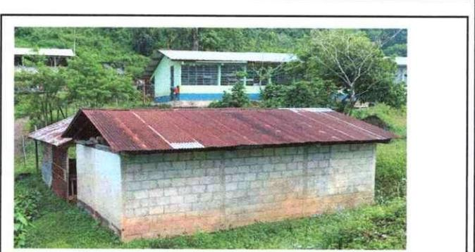
Se observa el deterioro de las laminas del techo de la cocina.
