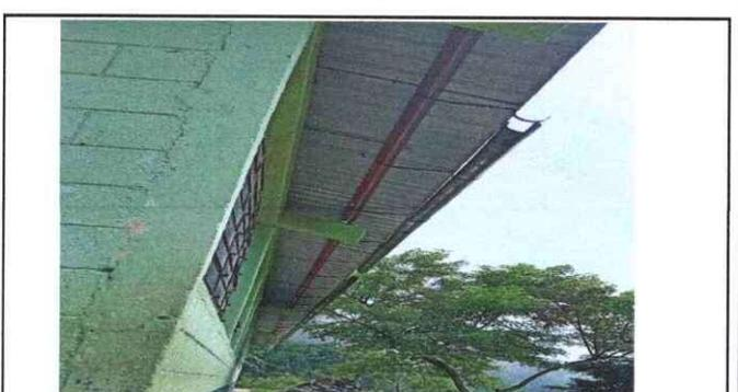
Se observa el deterioro de los canales de bajadas de agua pluvial.
